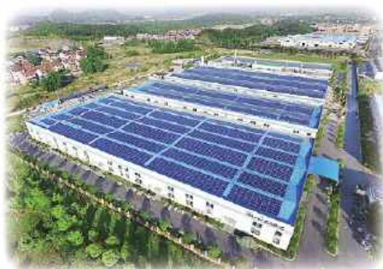
厂房光伏发电系统
