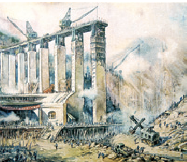
工地（新安江水电站）（水彩画） 1959 潘思同
