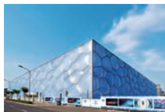
“水立方”使用了乙烯—四氟乙烯 聚合物薄膜
